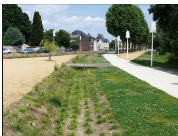
*Exemple d'ouvrage hydraulique : noue paysagère. Cet ouvrage permet de collecter et de réguler les eaux de pluie et de ruissellement en ralentissant leur écoulement vers un exutoire. L'eau ainsi canalisée dans la noue permet une infiltration régulée et continue, réduisant le volume d'eau du point de collecte à l'exutoire ou par infiltration vers la nappe phréatique.*
